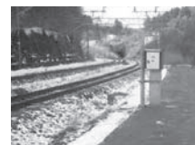
図-7 ケーブル埋設箇所の施工（ナクサR-PET）
